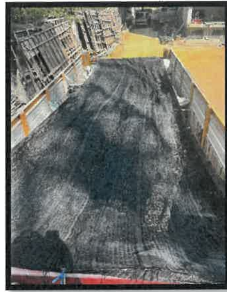
รูปที่ 3-7 ปิดคลุมรถบรรทุกด้วยผ้าใบอย่างมิดชิด
